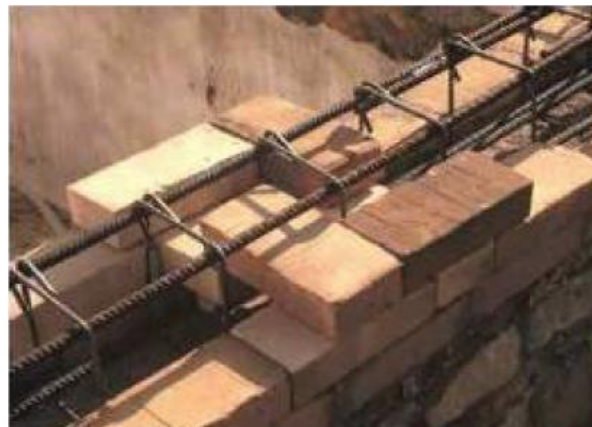
Esempio di cordolo in muratura armata
