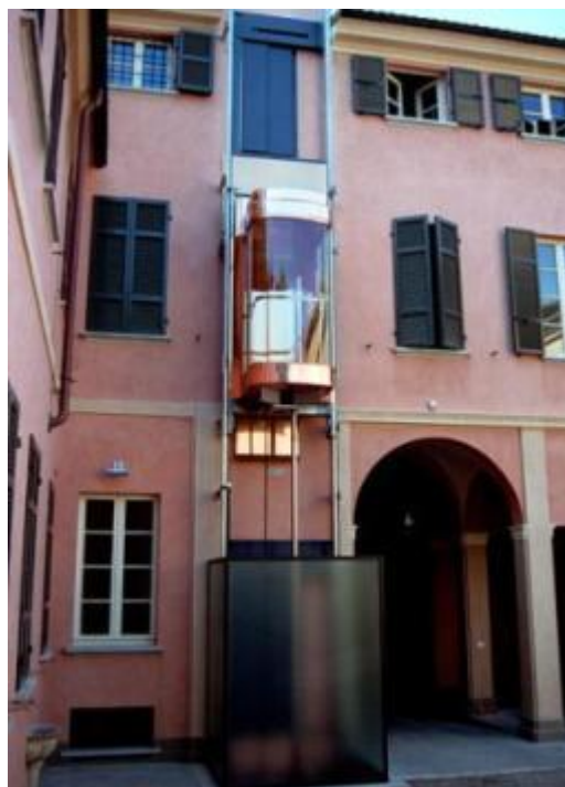
Inserimento di ascensore esterno in edificio storico.
